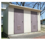
玉川橋団地 (大阪府高槻市)
