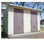
玉川橋団地 (大阪府高槻市)
