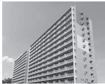
今回募集棟の一部(103・104号棟) ※写真は令和4年11月撮影
