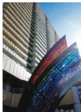
武庫川(兵庫県西宮市)
